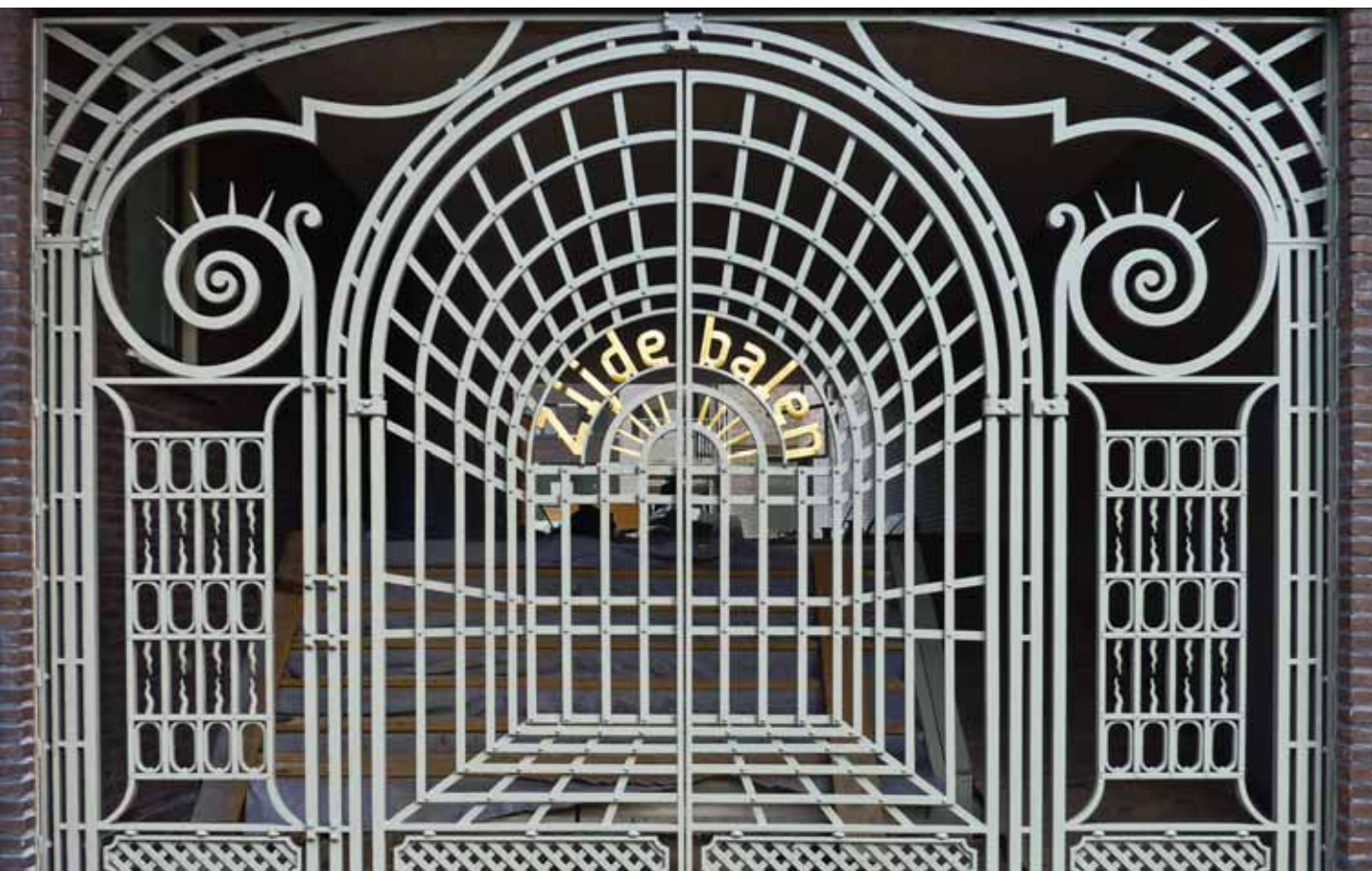
De meeste verbindingen in de toegangspoort zijn gesmeed, maar waar een las nodig is, wordt deze onzichtbaar gemaakt. (Foto: Van der Horst)
